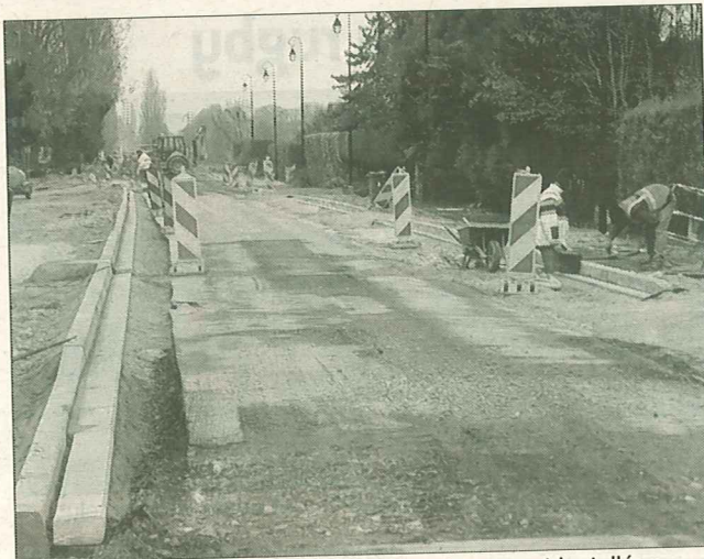
De chaque côté de la RD 105, des bordures sont installées sur trois cents mètres. Photo C. M.
