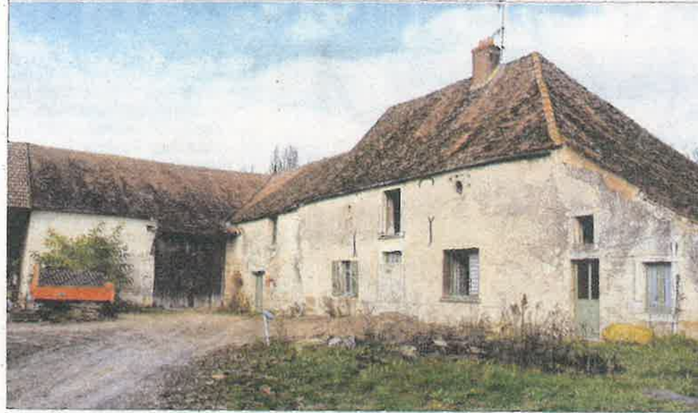
Avant démolition. La ferme Sarrazin était située entre la mairie et la Norges. Photo LBP/Ch. M.
