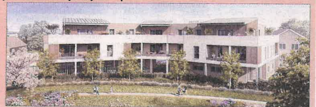
Le projet est porté par Coop Habitat Bourgogne. Visuel Coop Habitat Bourgogne
